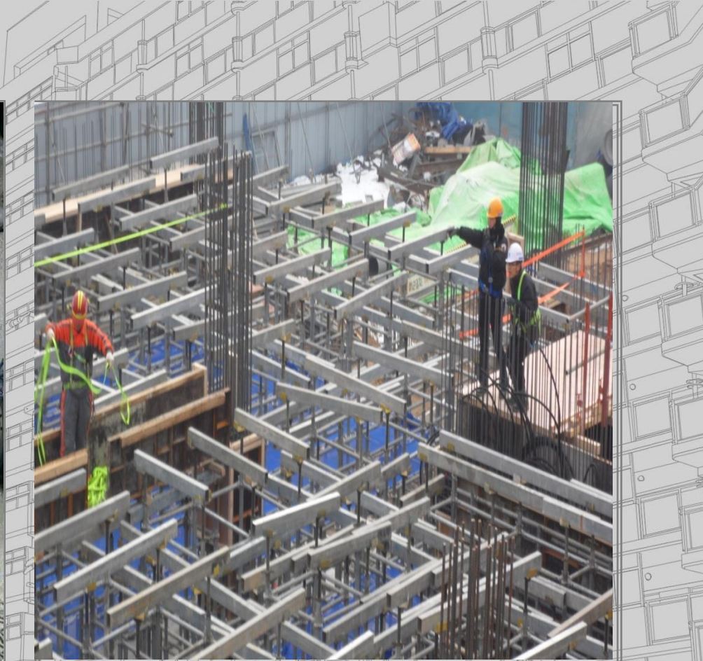
[ 가시설 설치 안전점검 ]
